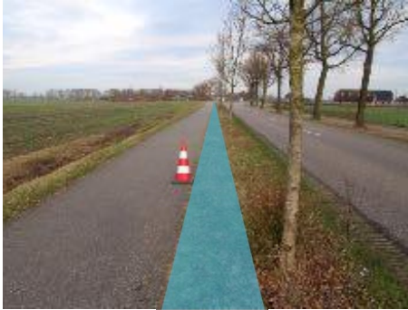
Figuur 5: In blauw is de locatie en het ruimtebeslag van de grindkoffer aangegeven. Rechts van de rijbaan zijn de grasbetontegels zichtbaar.
