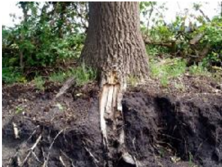
Figuur 3: Wortelbeschadiging door afgraving houtwal
